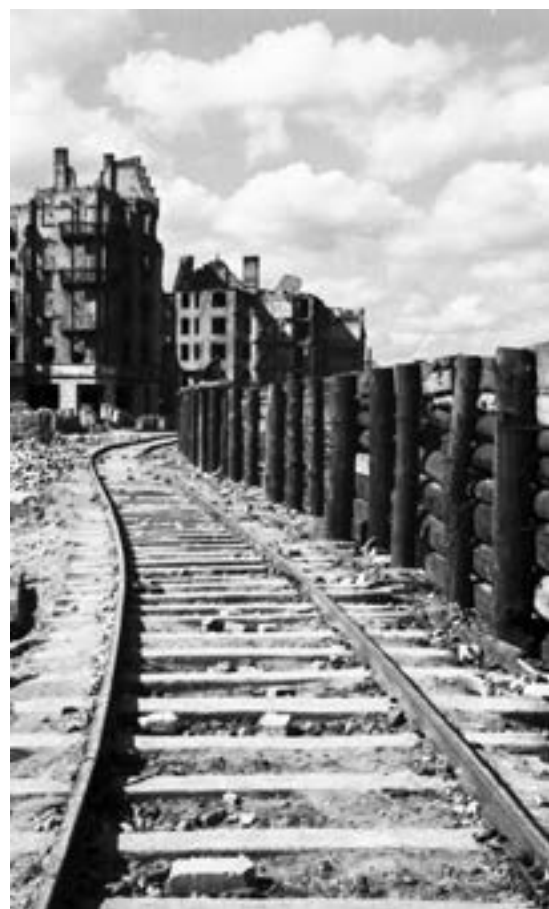
Szyny kolejowe, ułożone w celu usprawnienia sprzątania gruzów, doprowadzone do kościoła Mariackiego, 1946 r.
