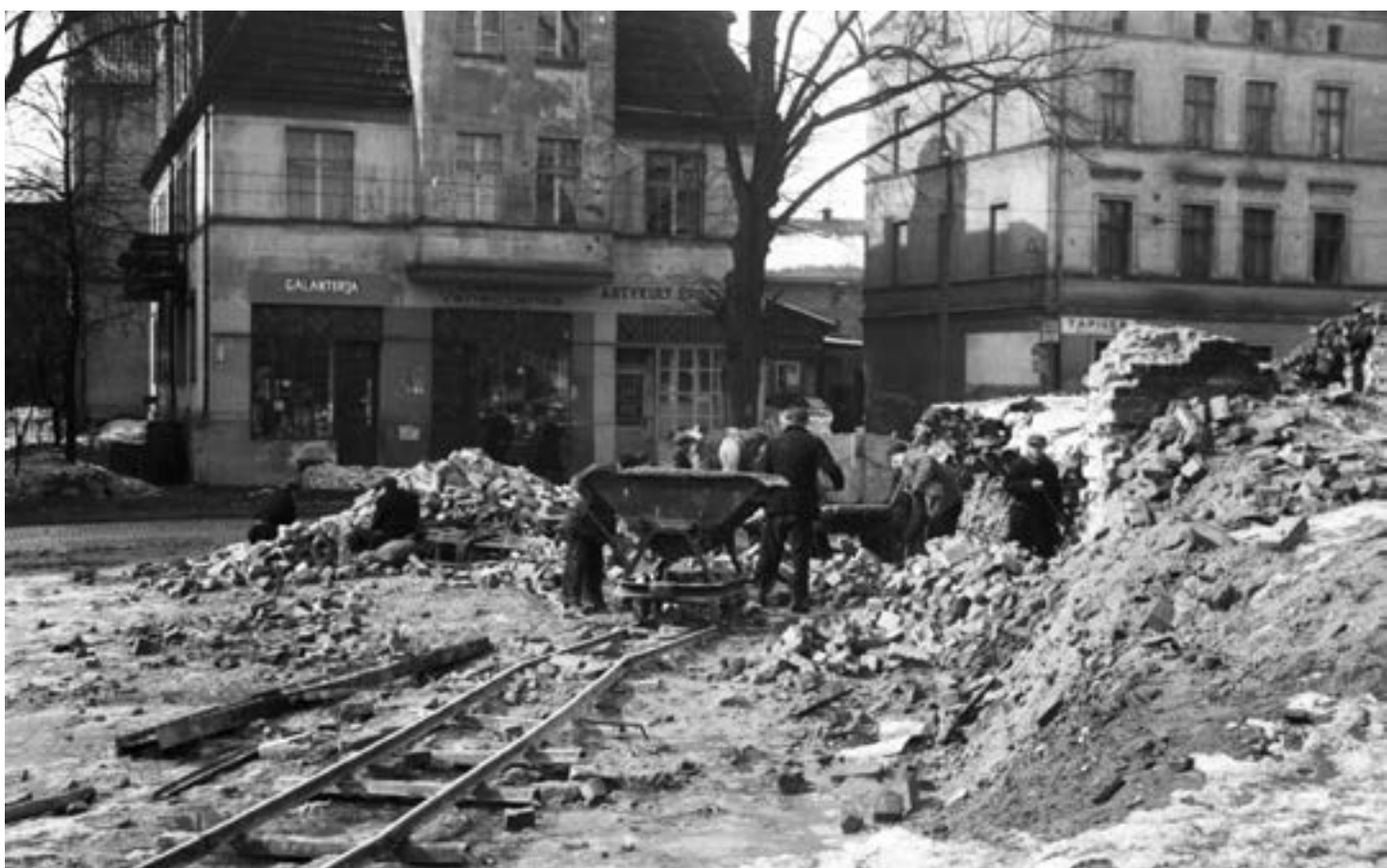
Usuwanie gruzów, 1946 r.
