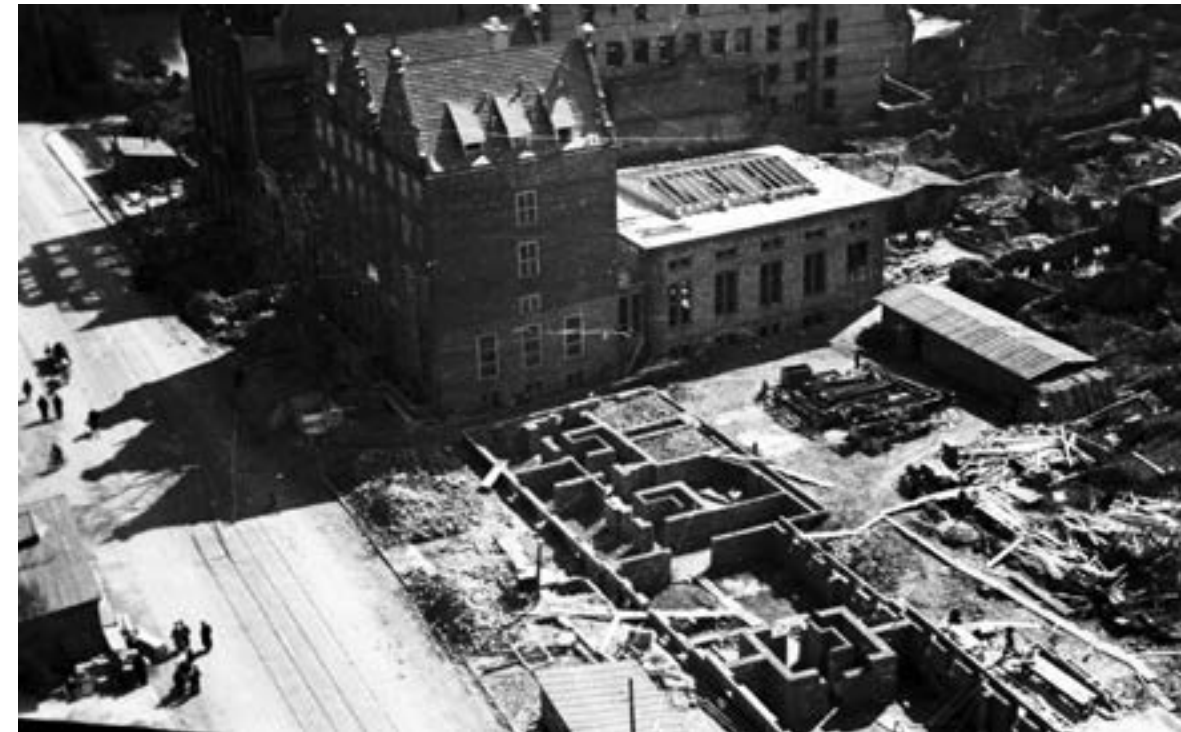
Widok z lotu ptaka na ulicę Długą, 1947 r.
