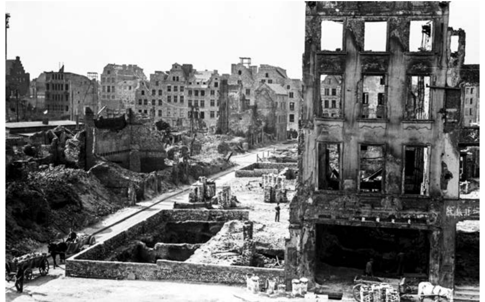
Widok na zrujnowane kamienice od ulicy Piwnej, 1949 r.
