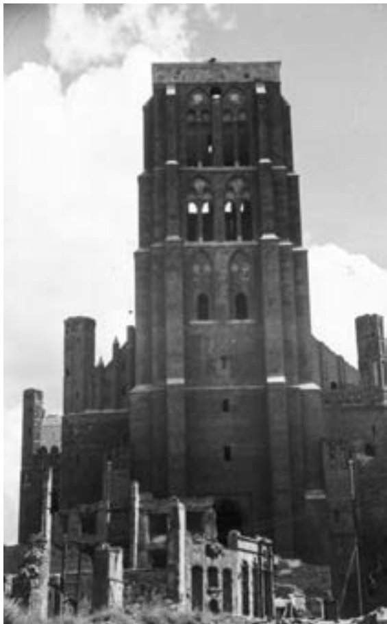
Widok na kościół NMP i zniszczone kamienice przy ulicy Piwnej, 1946 r.
