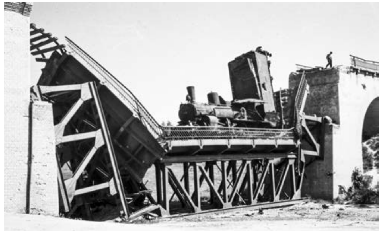
Bezpośredni przejazd z Oliwy do Śródmieścia był niemożliwy ze względu na zniszczony wiadukt i leżącą tam lokomotywę. Ulica Słowackiego i zburzony wiadukt, 1945 r.
