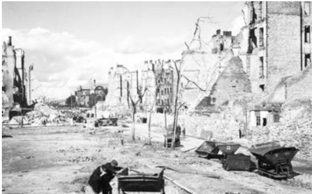
W wyniku działań wojennych przedwojenne ulice Pfefferstadt (Korzenna) i Paradiesgasse (Rajska) na Starym Mieście zniknęły. Pozostały jedynie ruiny, stan ok. 1946 r.
