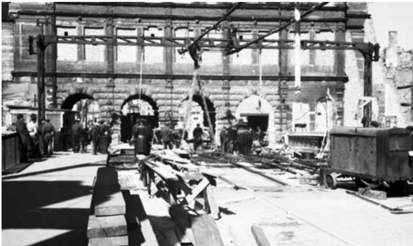
Zielona Brama po zakończeniu wojny była w bardzo złym stanie technicznym. W 1946 r. w celu jej zabezpieczenia postawiono w miejscach dawnych ścian dwie przypory wzmacniające niestabilną konstrukcję korpusu głównego, a w celu skutecznej ochrony przed wpływem czynników atmosferycznych zamurowano otwory okienne w ścianach pierwszego piętra. Na zdjęciu Zielona Brama w odbudowie, 1946 r.
