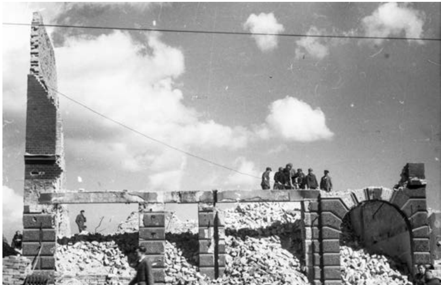
Aleja Grunwaldzka, rozbiórka zniszczonych gmachów, 1945 r.
