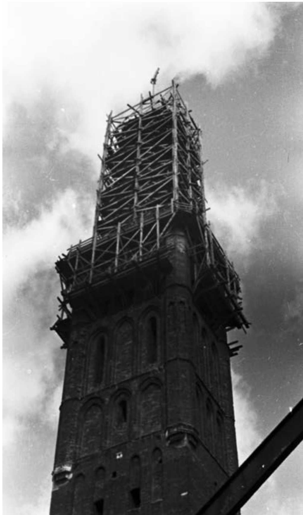
W 1949 r. przystąpiono do rekonstrukcji hełmu ratusza. Prace rozpoczęły się od umocowania drewnianego rusztowania, a 4 sierpnia 1949 r. robotnicy zawiesili na wieży ratusza głównomiejskiego wiechę.
