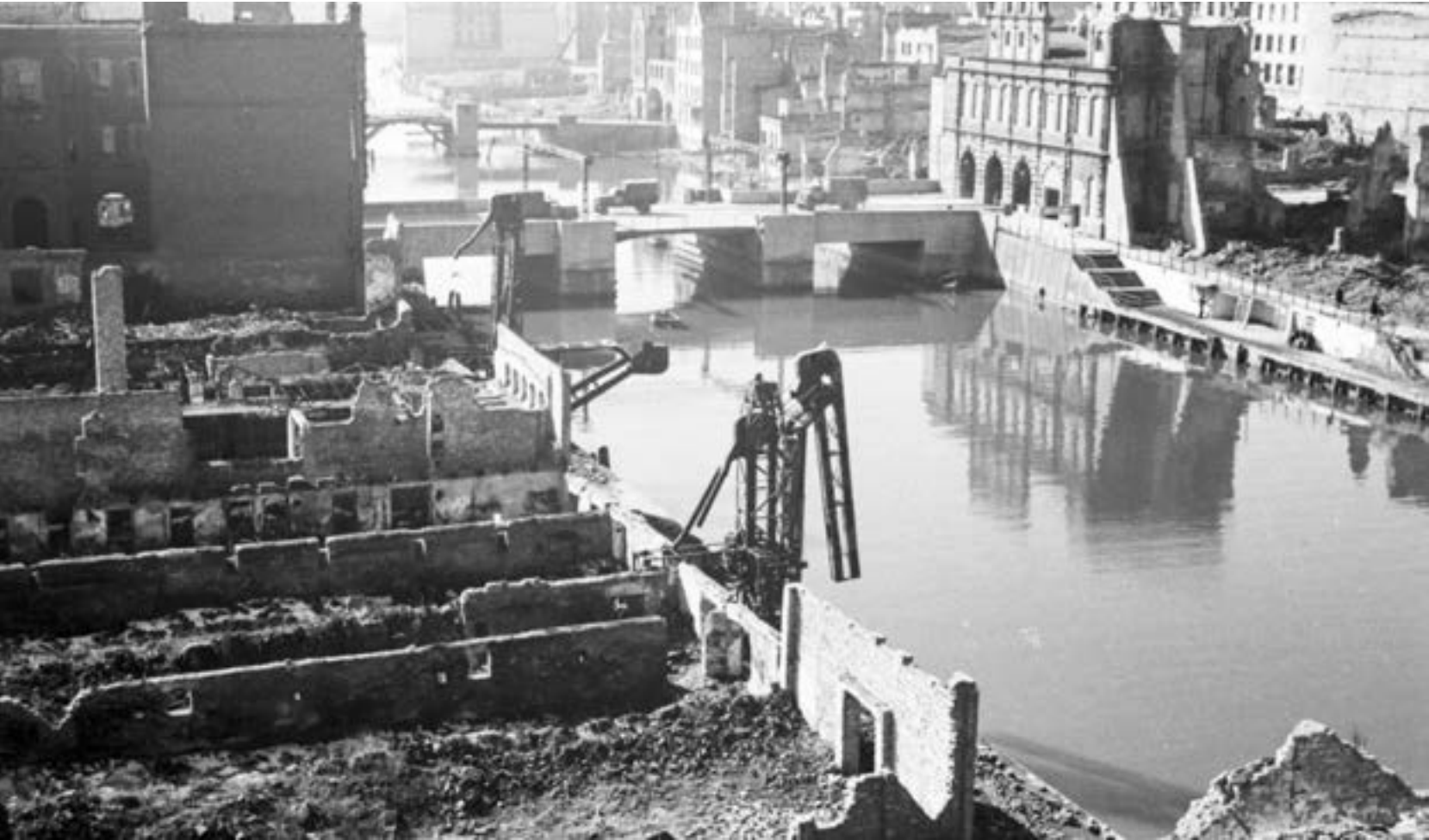
Widok na zniszczone magazyny na Wyspie Spichrzów, Motławę i Zieloną Bramę, 1946 r.
