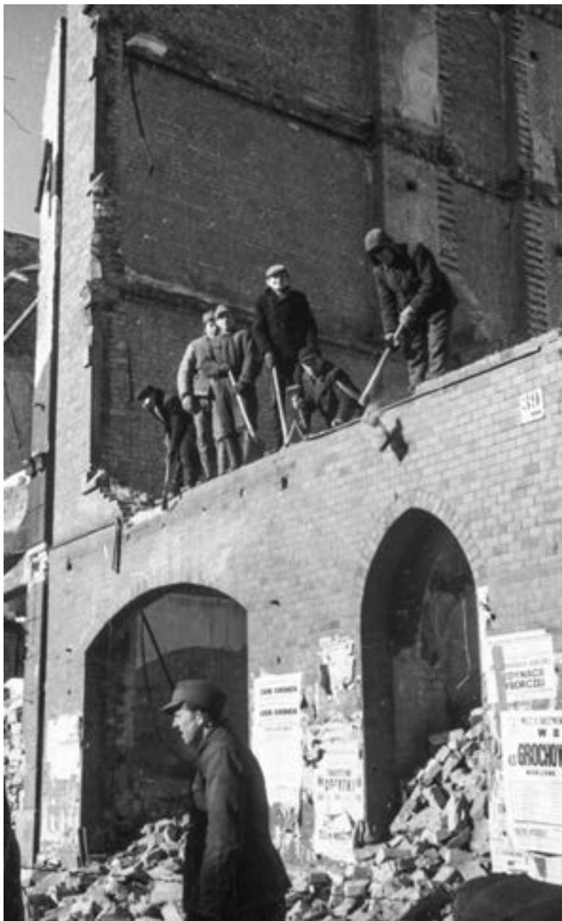
Prace rozbiórkowe, aleja Grunwaldzka, Wrzeszcz, ok. 1946 r.
