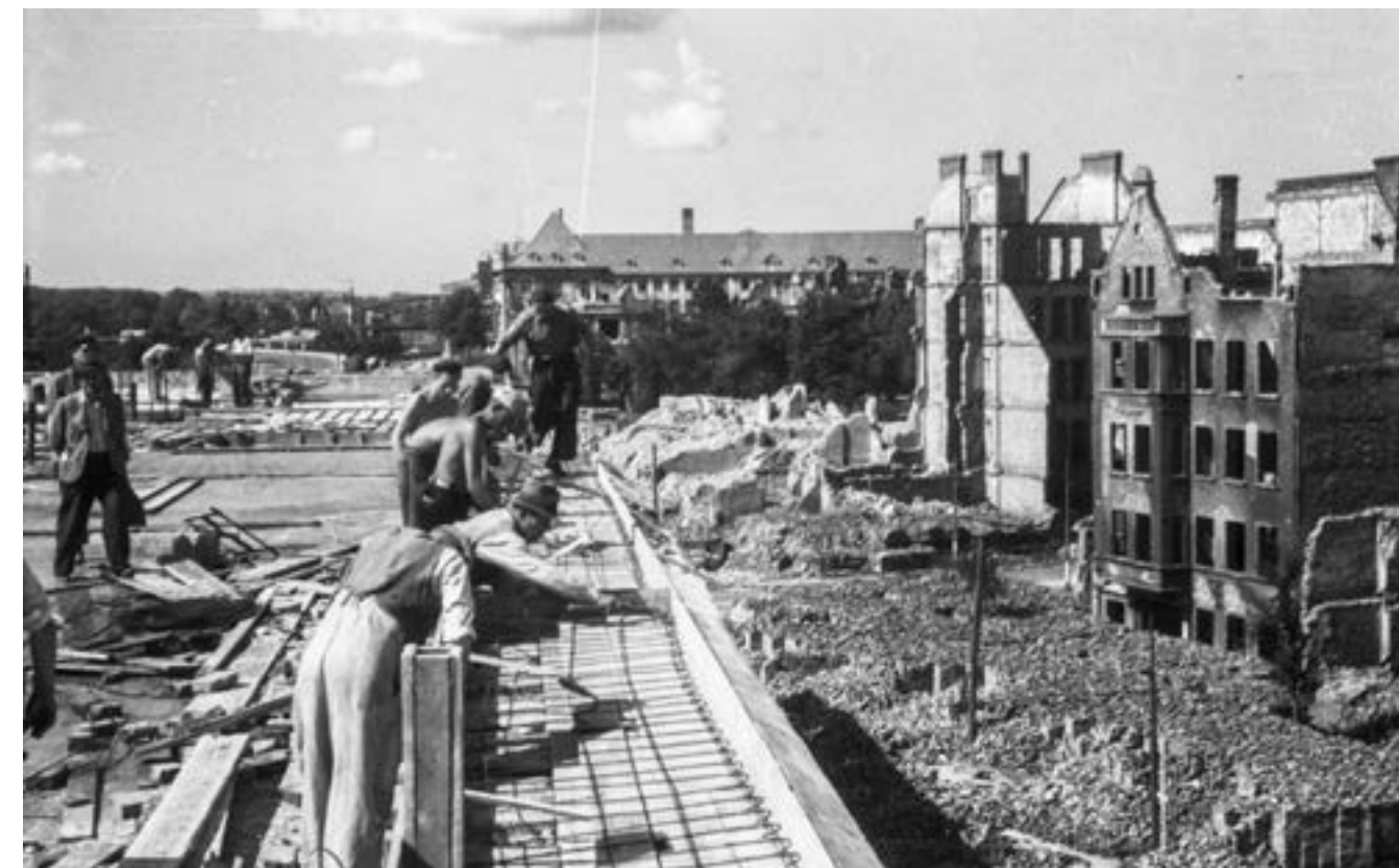
Budowa hotelu „Monopol” naprzeciw Dworca Głównego, 1947 r.
